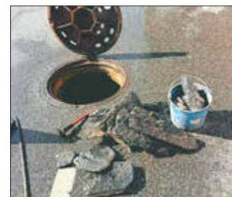
Im Rahmen der Spülung und Filmung des Hauptkanals in der Hauptstraße zwischen Marktplatz und Im Solch wurden in Teilbereichen massive verfestigte Ablagerungen von Mörtel- und Betonresten vorgefunden. Die Ablagerungen störten den Ablauf, sodass es zu Rückstauereignissen im Kanal kam.
