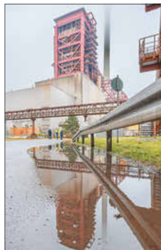
Der 120 m hohe Freiluftkessel des Kraftwerks WEIHER Foto: Giancarlo Albrecht
